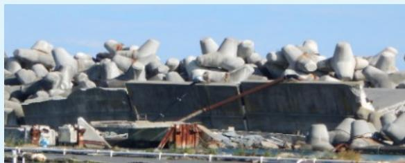
壊れた防波堤の上に設置されている仮設の防波堤
