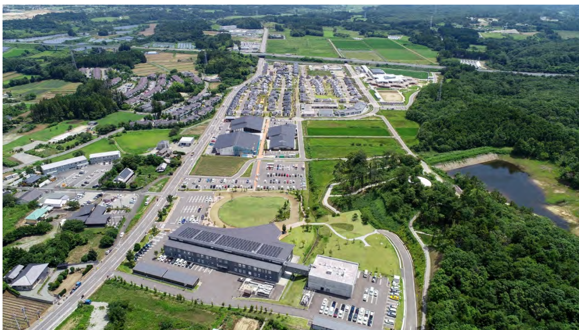
大川原地区復興拠点の様子（令和5年7月撮影）
