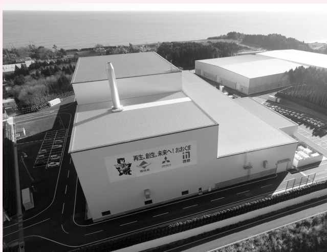
稼働した大熊町仮設焼却施設
